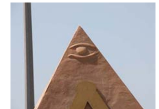
Detail van de topsteen
