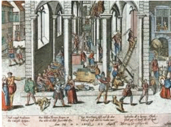
Beeldenstorm, sloop de kerken!
